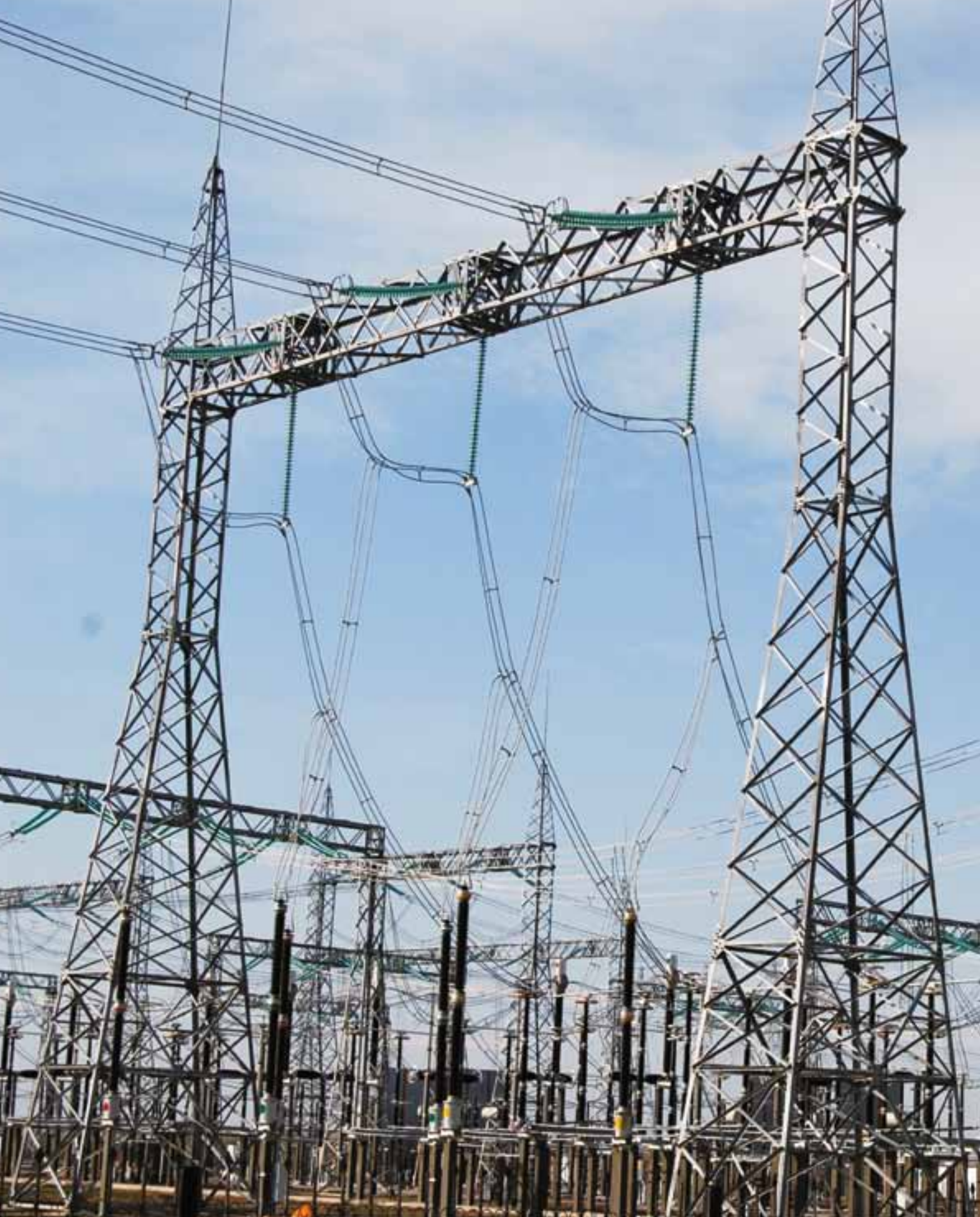
Строительство ПС-500кВ «Шу» (1 – 2 этапы)
