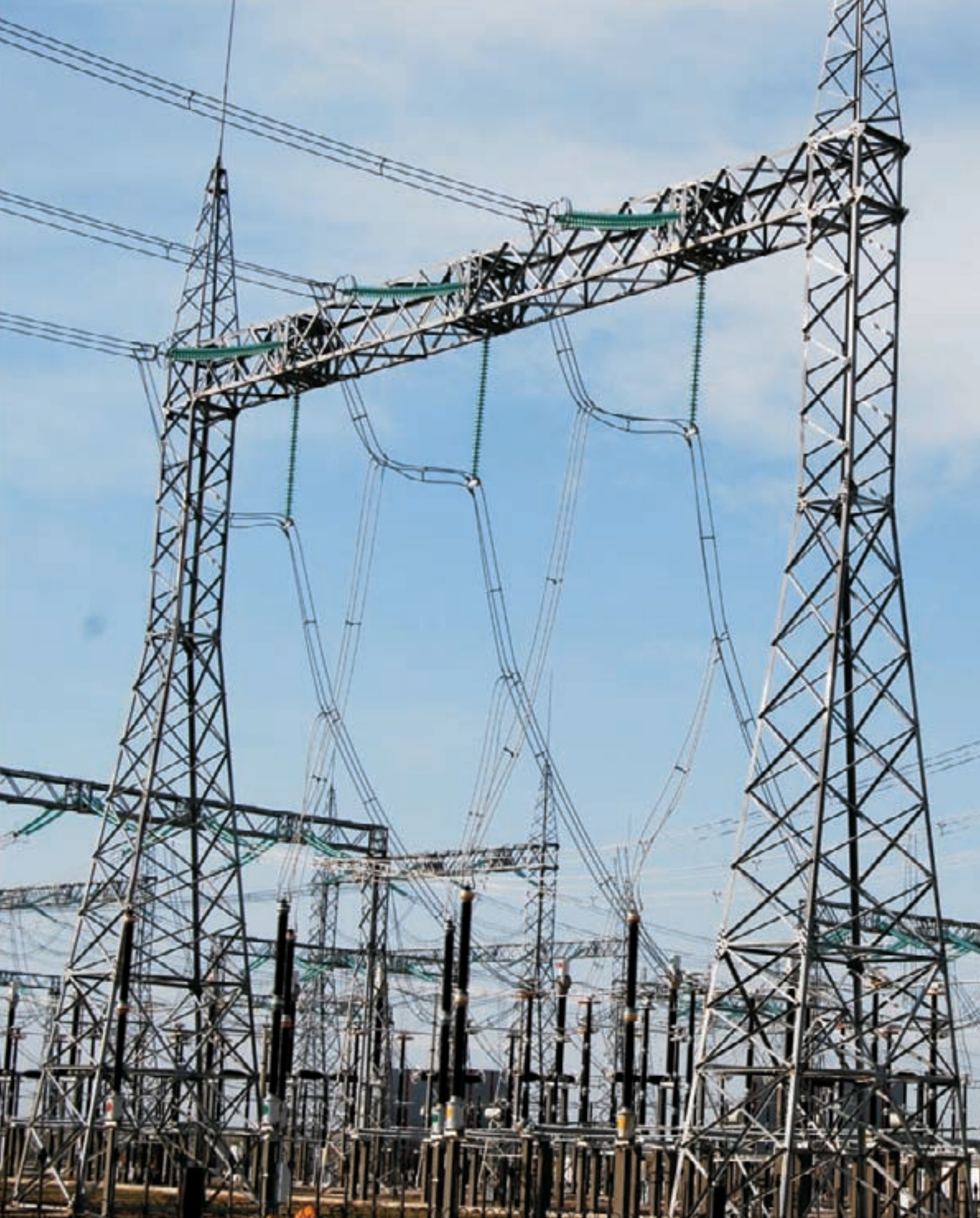
Строительство ПС-500кВ «Шу» (1 - 2 этапы)
